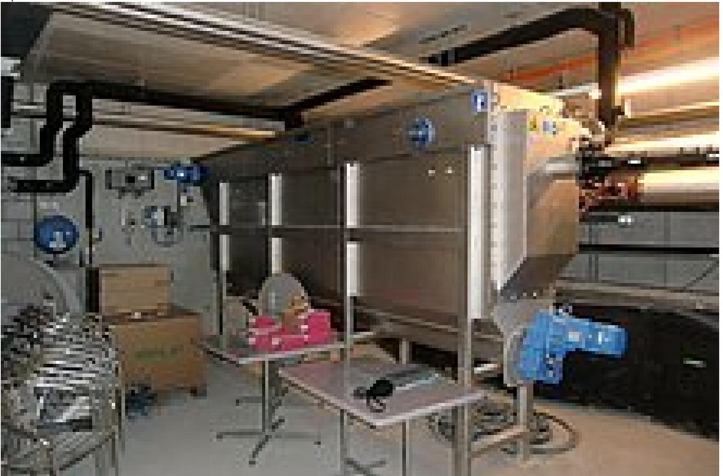
Figura 4: Scambiatore di calore nel magazzino accanto al locale caldaia.
