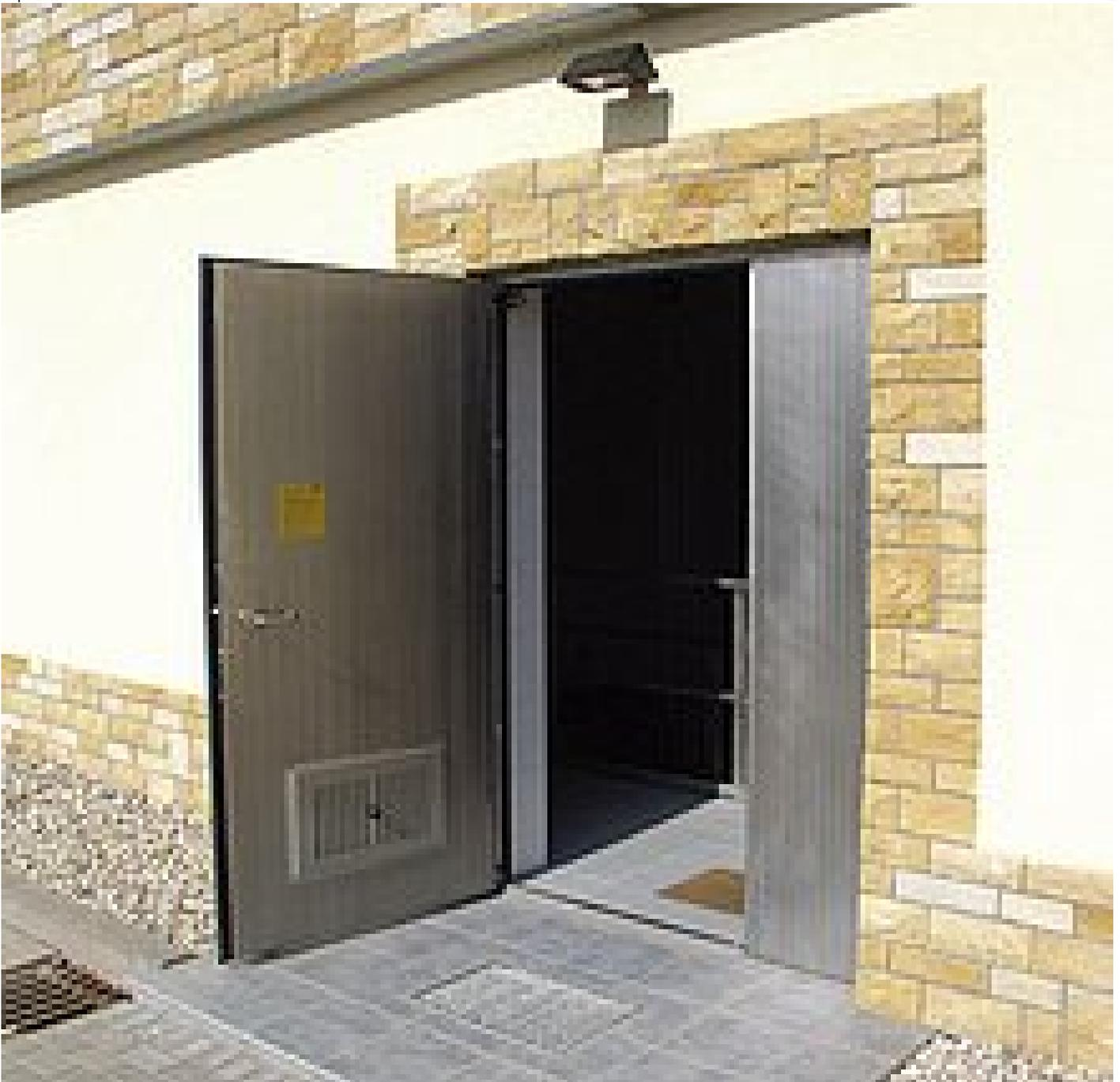
*Porta di sicurezza anti-effrazione TT2, classe di resistenza RC3, con certificato di collaudo*
