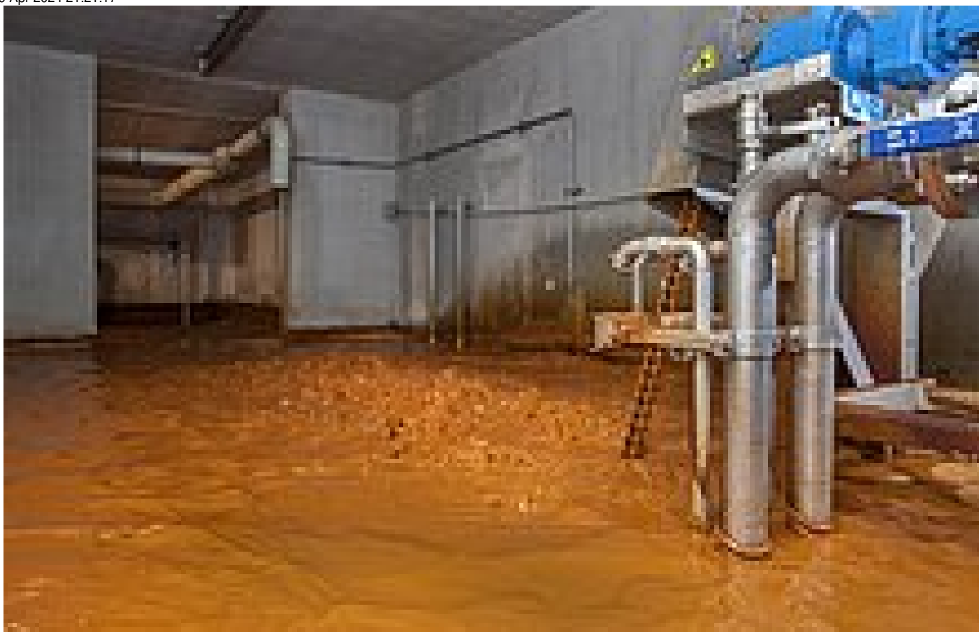
Figura 4: Bioreattore a membrana, una camera di filtrazione con il sistema di filtrazione a membrana HUBER VRM® 30/18 RF
