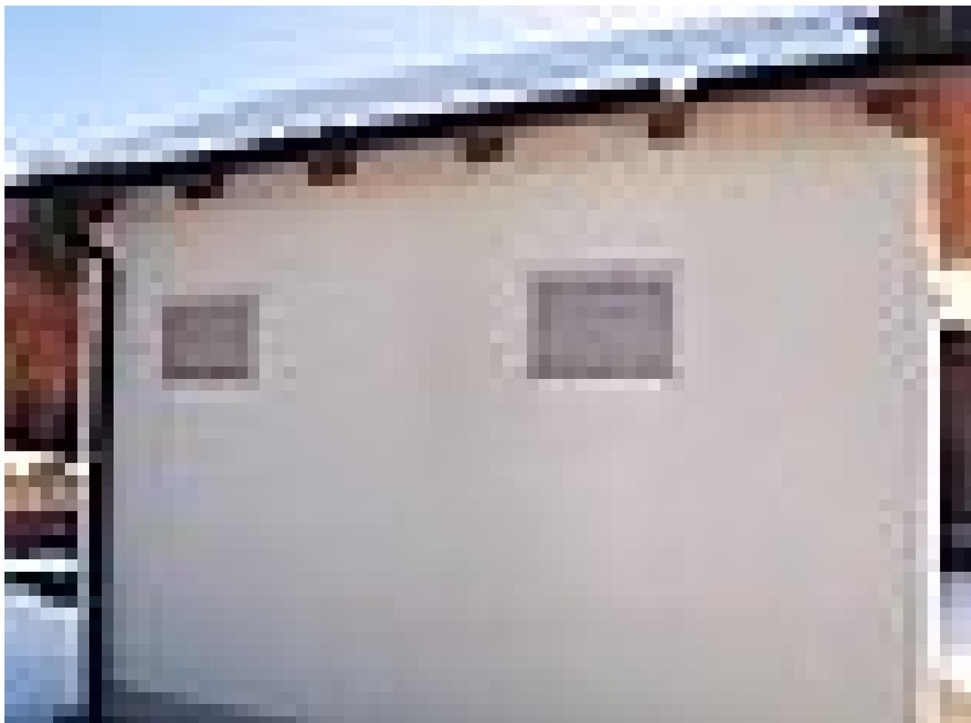
Grille d'aération, anti-effraction, prête à poser, version fixe, tout inox 1.4301/1.4307.
