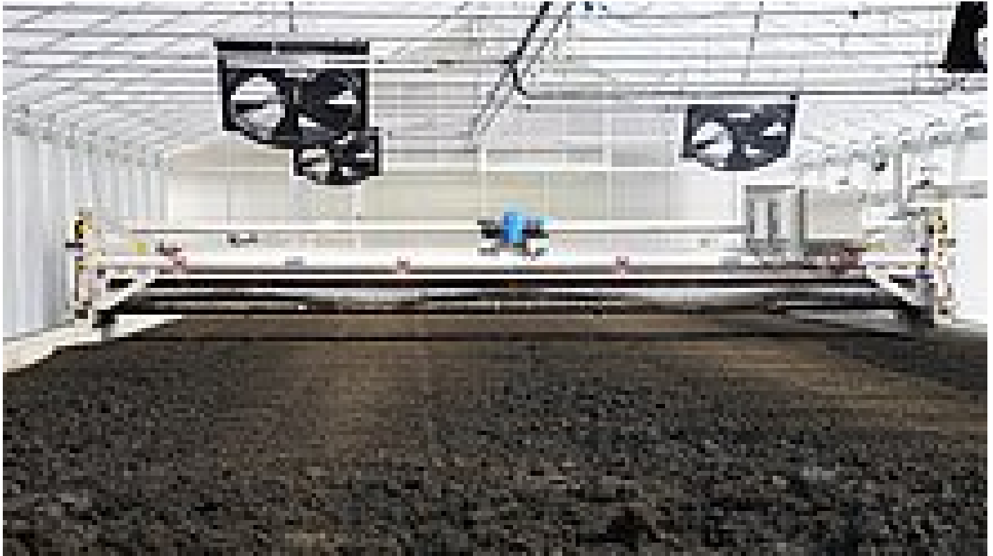
Le retourneur de boues SOLSTICE® d'HUBER permet un séchage solaire efficace
