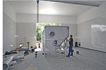
Nous avons assisté techniquement au niveau du levage et manutention notre client final qui avait à sa charge le déchargement et la mise en place de l'équipement. La charge du pré traitement a été répartie sur plusieurs paires de pieds supports intégrés au caisson du Ro5.
