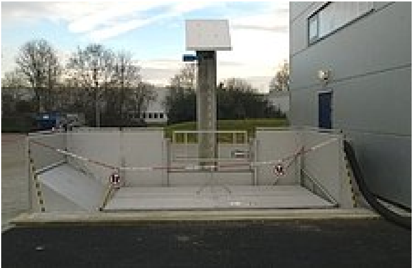
Procédé de réception des sables RoSF5 HW avec couverture automatique de la trémie de réception sur la station d'épuration de Francfort-Niederrad
