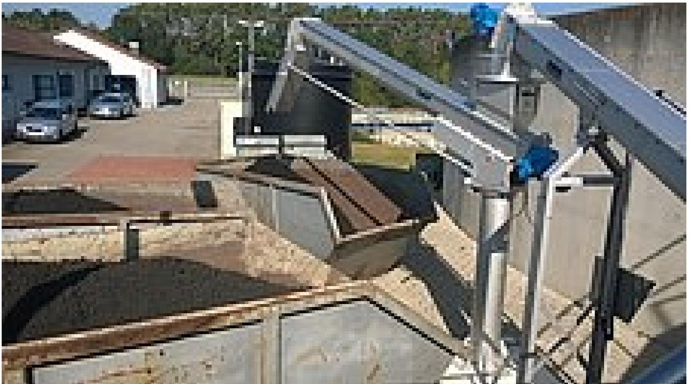
La HUBER Vis de transport en auge Ro8 T de HUBER pour boues déshydratées sur le Hausen KA. Le système d'évacuation à rotation libre avec glissière réglable pour un chargement simple et variable des conteneurs.
