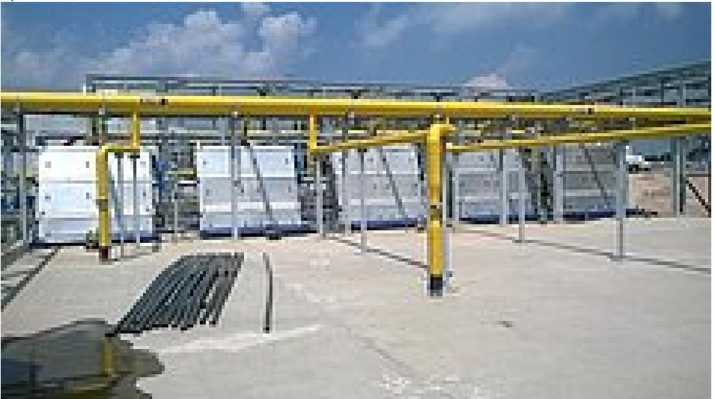
*Atotonilco WWTP, première des deux lignes de râteliers avec 5x HUBER RakeMax® 5300x2752x35. Introduction directe dans un caniveau alimenté HUBER Launder Channel HLC 450 de 30 m de long*
