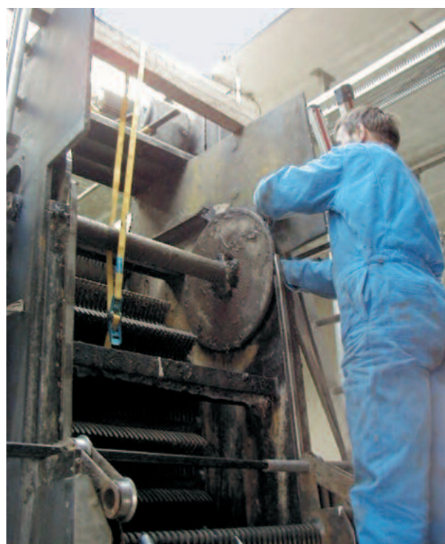
Révision totale d'un dégrilleur AQUA GUARD
