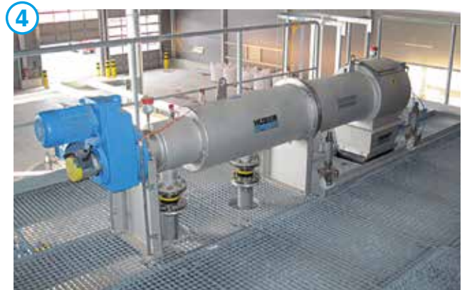
HUBER Fremdstoffabscheider STRAINPRESS®.
