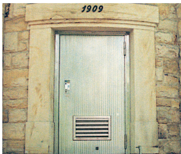
Porte de sécurité anti-effraction TT 2.1, avec jalousie
