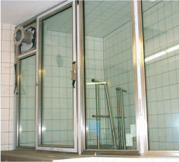
Porte vitrée de séparation
