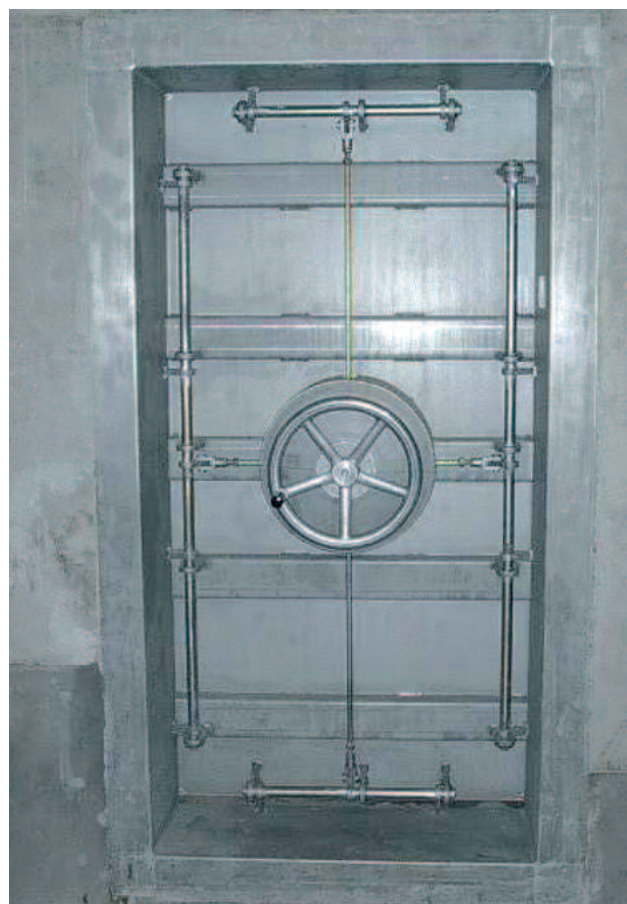
Porte étanche à l'immersion avec verrouillage centralisé TT 7.Z (vue extérieure)
