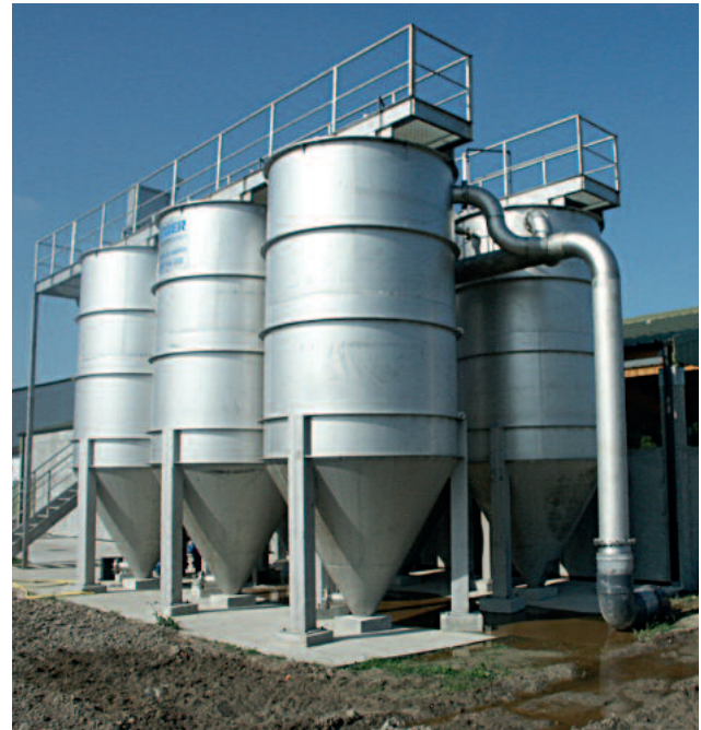
HUBER Sandfilter CONTIFLOW® CFSF 51, Montmartin, Frankreich
