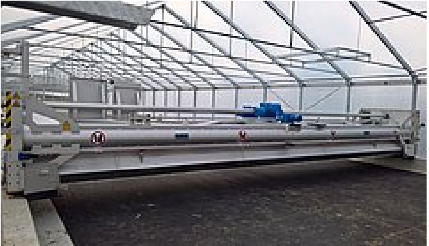
Der HUBER Schlammwender SOLSTICE® kurz vor der Inbetriebnahme
