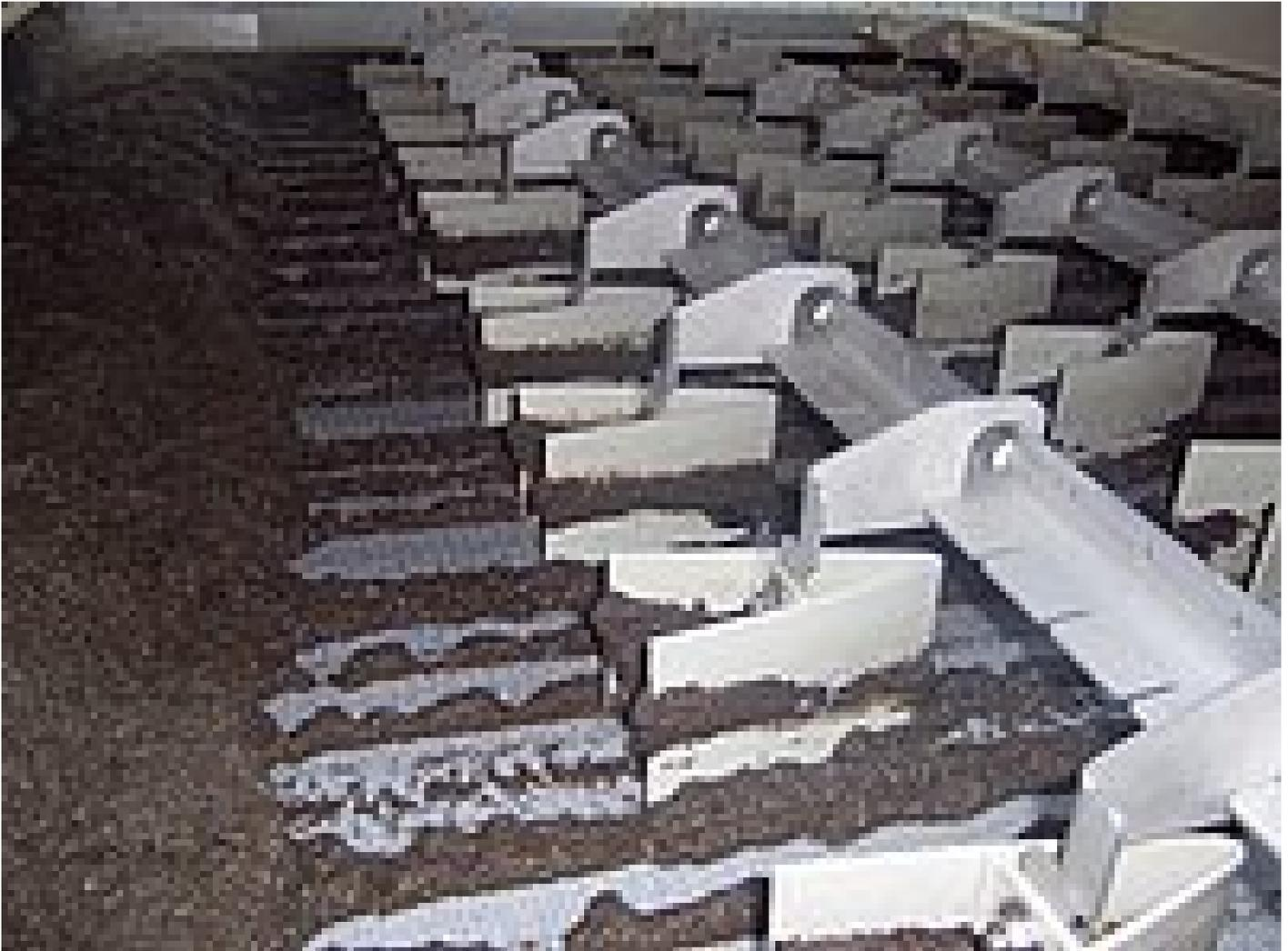
*Vollflexible Dreiecksschikanen zur Schlammumschichtung*
