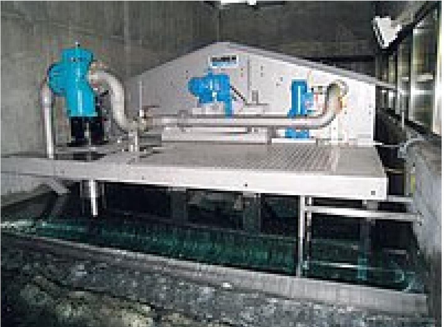
*RoDisc® 10 eingebaut im Einlaufbauwerk; von hier führt eine 10 km lange Leitung zum Trinkwasser-Kraftwerk*
