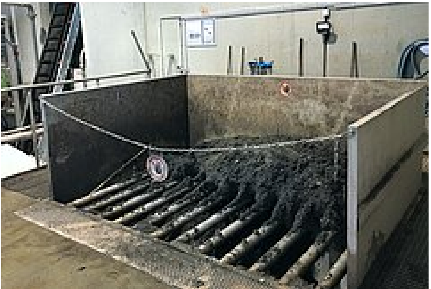
HUBER Horizontale Sanddosierschnecke RoSF7 mit Bunker und Störstoffabscheider
