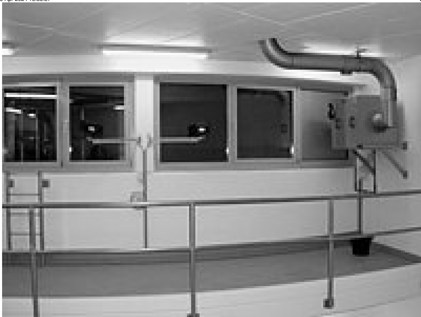
Vom Bedienhaus abgetrennte Wasserkammer
