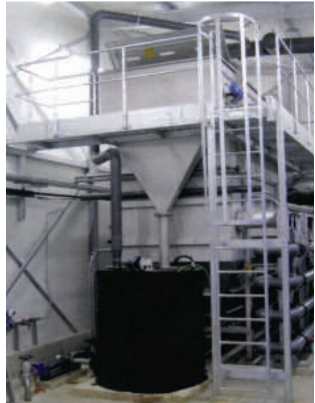
HUBER Druckentspannungsflotation HDF 10 während der Inbetriebnahme
