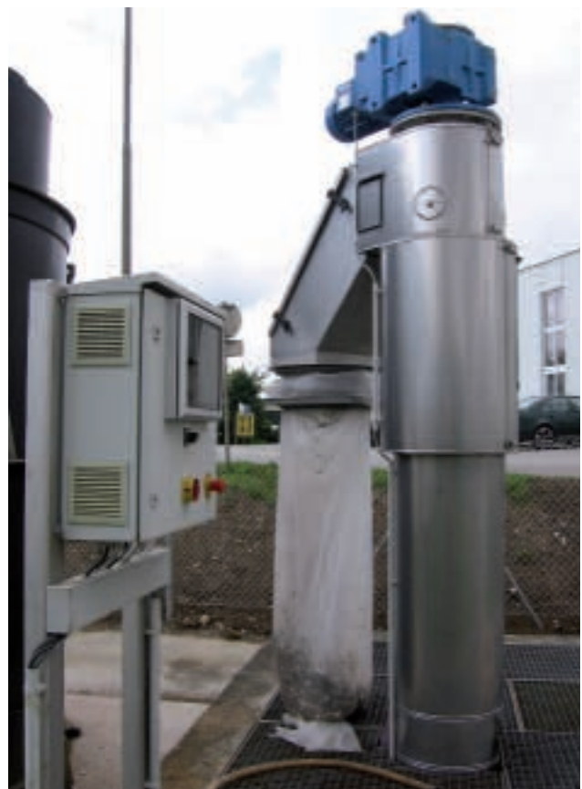
HUBER ROTAMAT® Schachtsiebanlage RoK 4-700-3, isoliert
