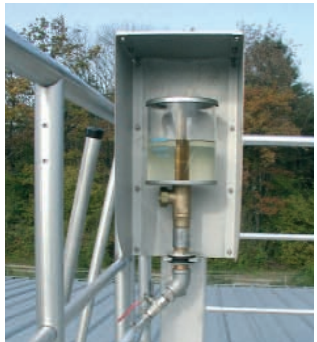
Leckageüberwachung für das Lager der VRM ®
