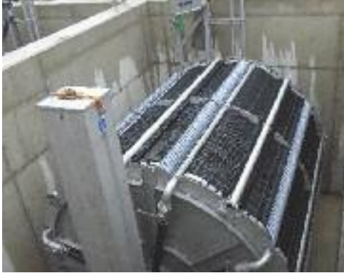
Unità di filtrazione VRM® 30 installata in un impianto municipale per il trattamento acque
