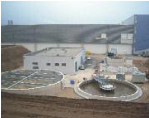
Gestione delle acque di scarico impianti industriali, Hans Kupfer & Sohn, con tre unità VRM® da 30/400
