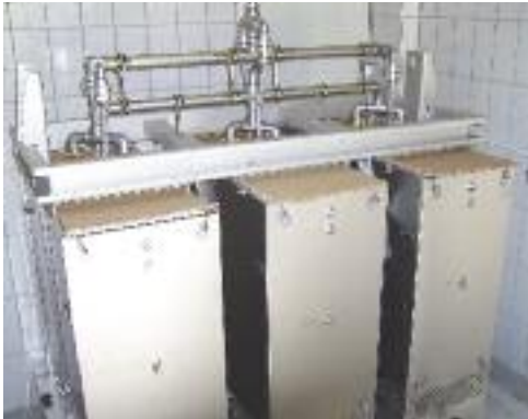
Esecuzione modulare – installazione con 6 moduli, superficie membrana 84 m 2
