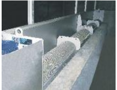
ROTAMAT® Griglia a stramazzo RoK 2 installata a monte dello stramazzo
