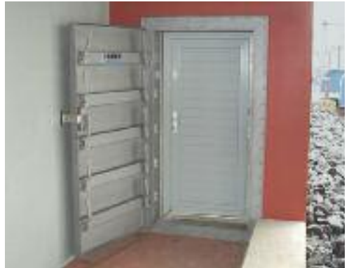
Porta a pressione per protezione da allagamenti
