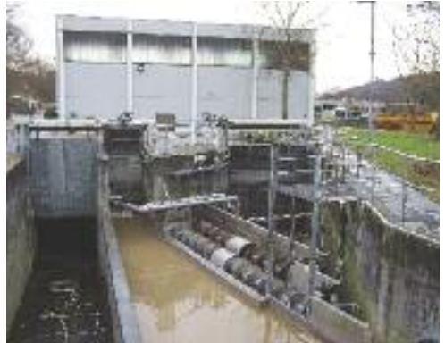
Combinazione di Griglie per una gestione ottimale di scarichi con elevate portate
