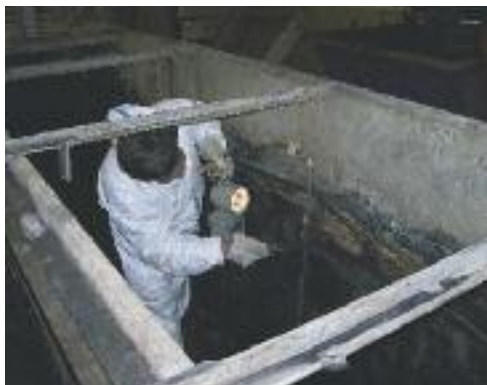
HUBER Service per revisioni
