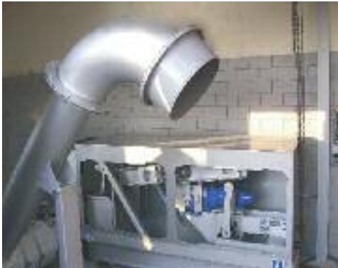
Griglia compatta a barre curve CurveMax® per separare efficacemente parti solide dalle acque di scarico
