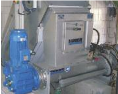
Pressa con Lavaggio WAP installata dopo un STEP SCREEN®
