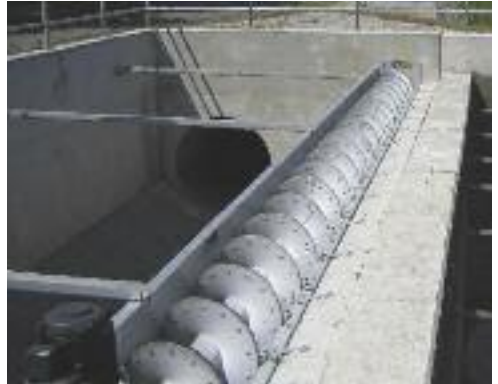
ROTAMAT® Griglia a stramazzo RoK 1 installato a valle dello stramazzo
