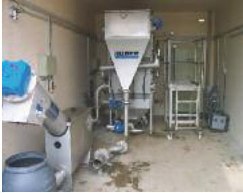
HUBER ROTAMAT® Filtrococlea con spaziatura da 1 mm ed impianto HUBER a Flottazione HDF
