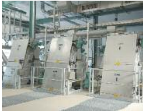
Griglia RakeMax® – robusta esecuzione per elevata affidabilità
