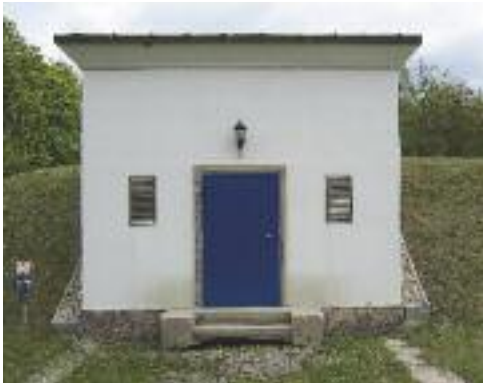
Serbatoio acqua potabile allestito con prodotti HUBER
