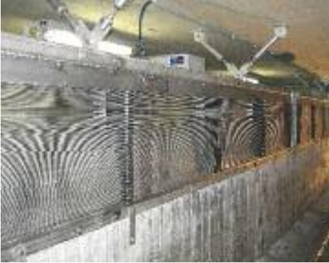
Griglia HSW installata verticalmente sulla chiusa di protezione da overflow
