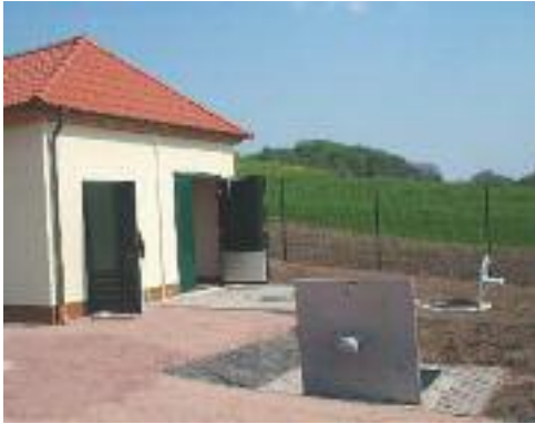
Unità MCB (dimensione 150 AE) per il trattamento decentralizzato di acque di scarico in una riserva naturale
