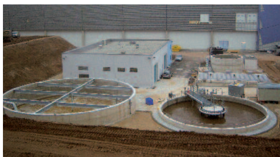
3 unités VRM® 20/400 avec 7200 m 2 de membranes sur le site de Hans Kufper & Sohn GmbH (Allemagne)
