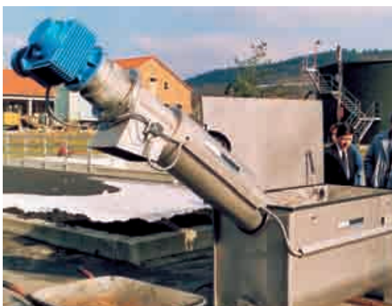
Essai réalisé sur une station d'épuration.
