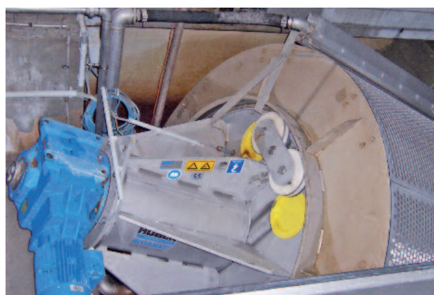
Installation im Gerinne
