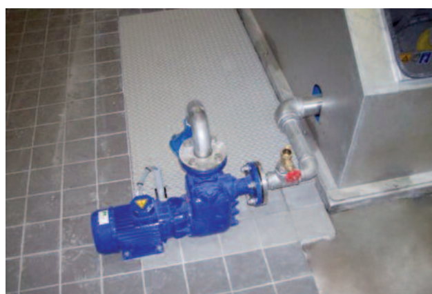
Selbstansaugende Kreis- oder Exzentrerschneckenpumpe zur Siebgutförderung
