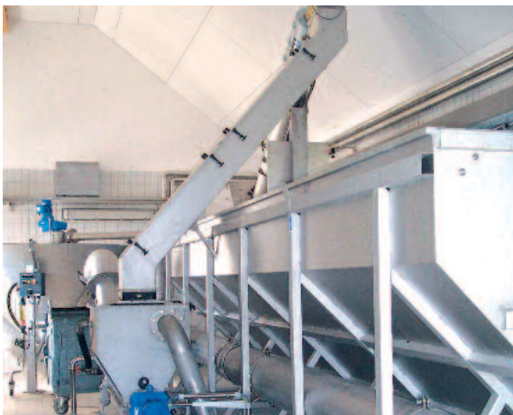
Presse laveuse intensive WAP/SL raccordée à une unité compacte Ro 5
