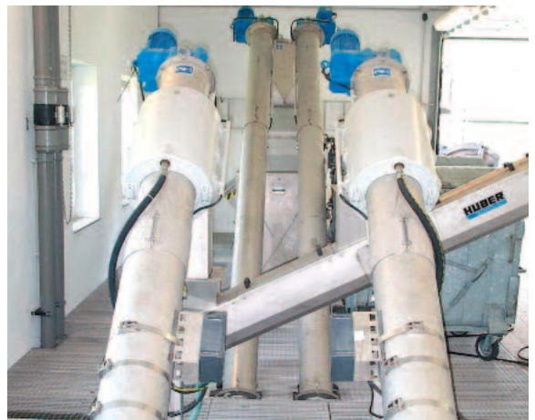
Installation de deux unités compactes Ro 5 en sous-sol
