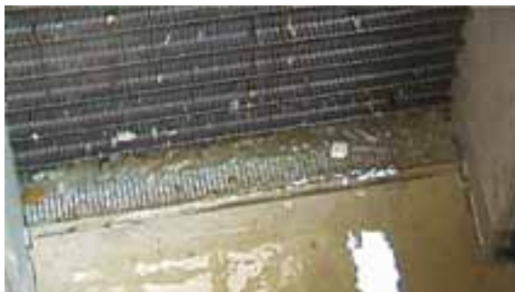
Exemple de pose d'un dégrilleur : la première marche est de niveau avec le radier du canal.
